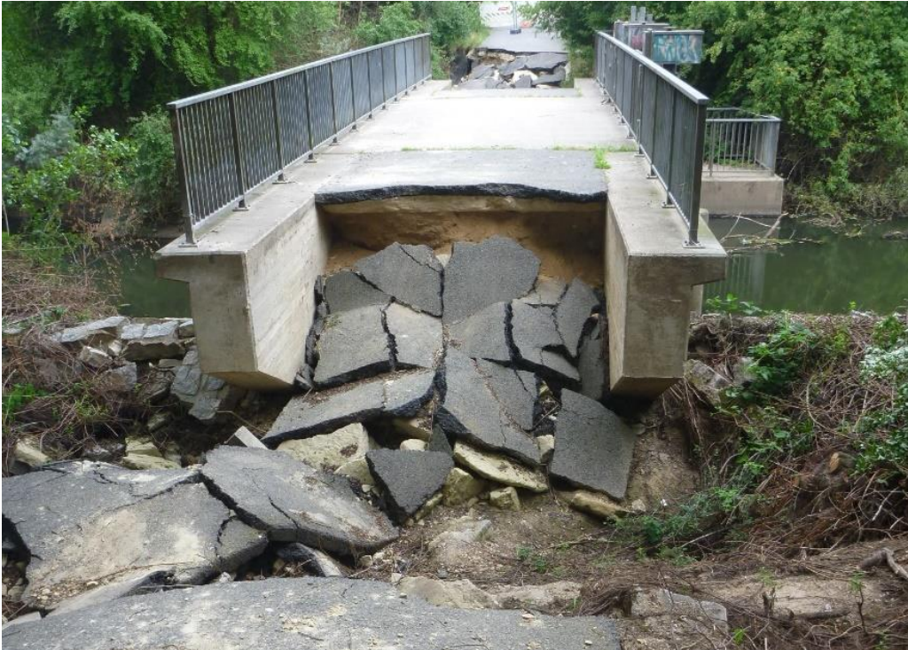
Abb. 1: Schäden durch Überschwemmung an der Glinder Au auf Grund von Starkregen am 10. Mai 2018 (ca. 50 mm pro Stunde), Bereich Steinbeker Teich (LSBG)
